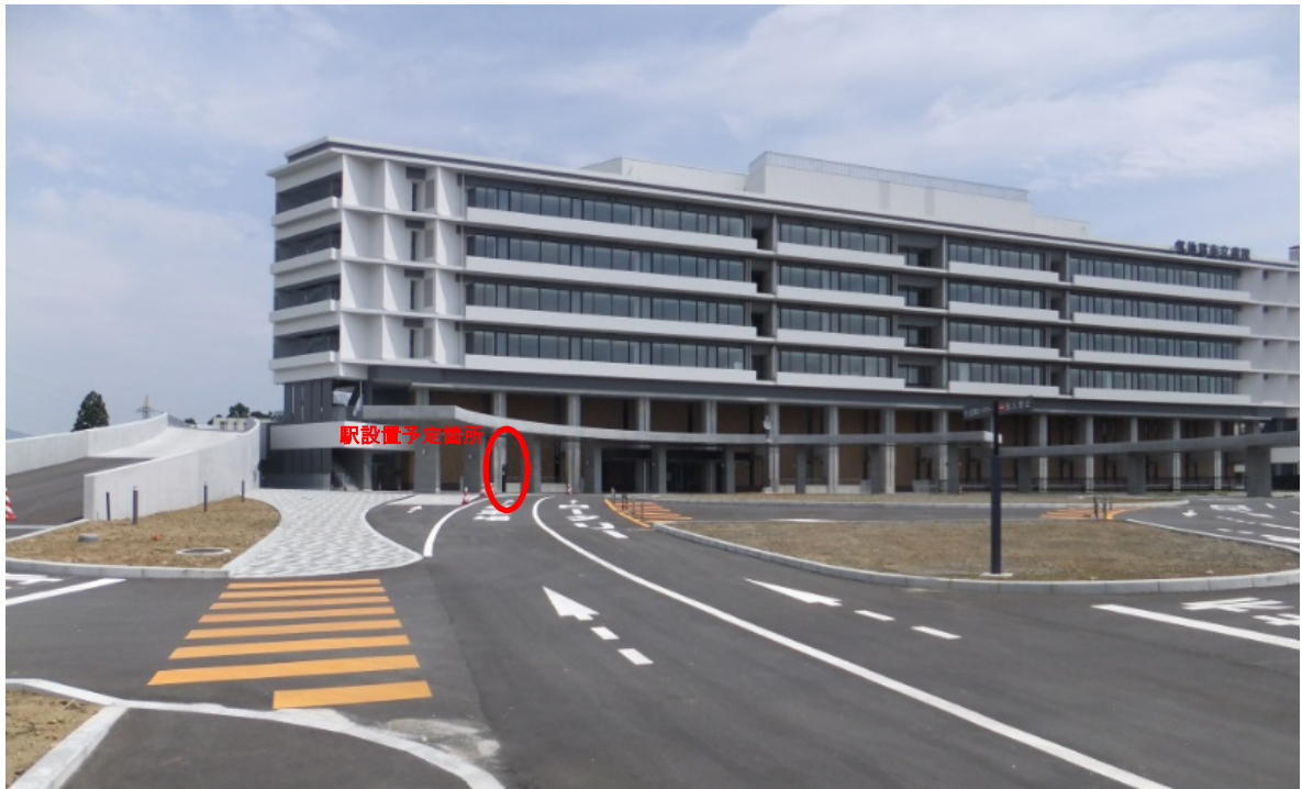
駅新設箇所写真(上図の矢印方向より撮影)《気仙沼市提供》
