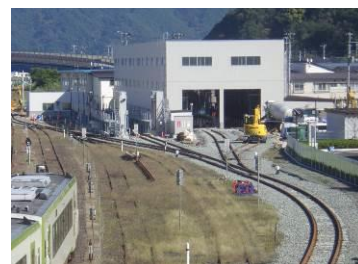
宮古駅(検修設備)
