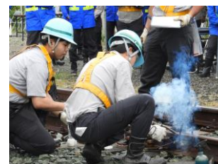
【レールの復旧作業】
