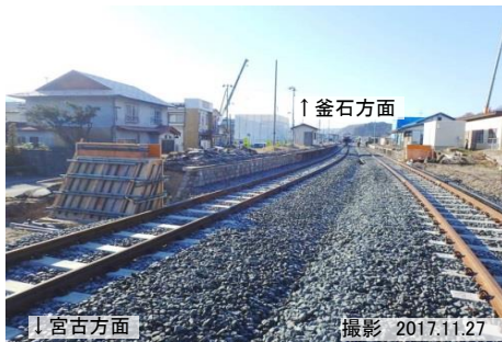
①津軽石駅付近(宮古市)
