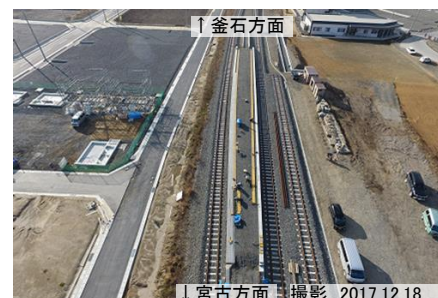
④鵜住居駅付近(釜石市)
