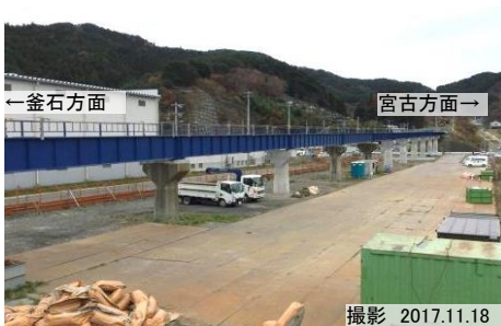
③大槌川橋りょう付近(大槌町)
