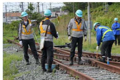
【線路点検をしている様子】
